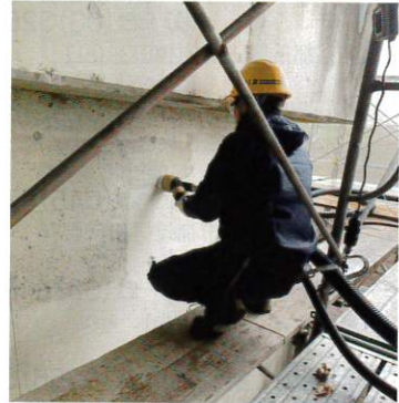
コンクリート橋脚 補強下地処理
