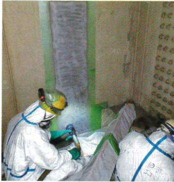
鋼橋塗り替え工事の素地調整
